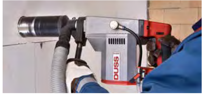
Dozen boren droog in kalkzandsteen met stofafzuiging
